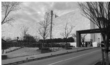
2 号館解体中（2023 年 2 月）
